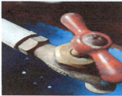
Foto 9: Sustitución de llave de chorro
