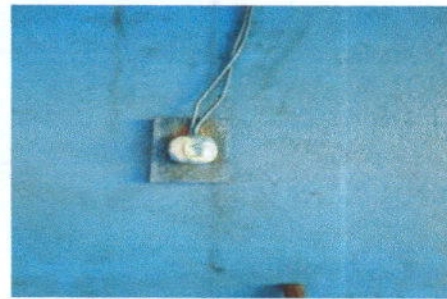
Foto 12: Sustitución de interruptores simples.
