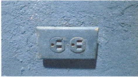
Foto 13: Sustitución de tomacorrientes dobles
