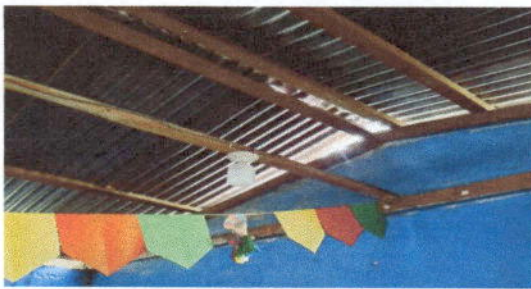
Foto 11: Sustitución de focos ahorradores y plafoneras y cableado eléctrico.
