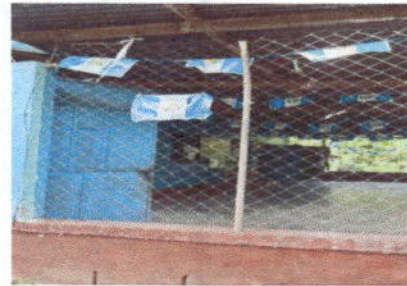
Foto 10: Reparación de tubo hg y malla galvanizada.
