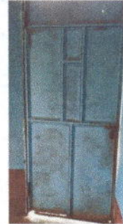
Foto 14: Fabricación e instalaciones de puerta de rejas
