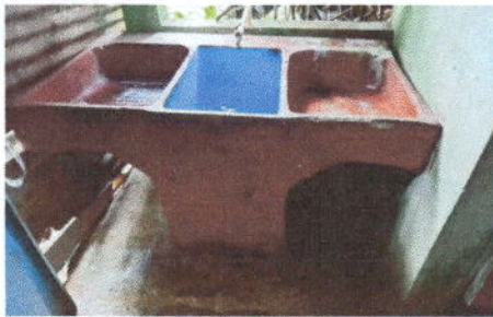
Foto 15: Sustitución de pila de cemento de dos lavaderos.
