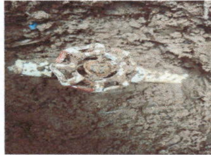
Foto 8: Sustitución de llave de cheque
