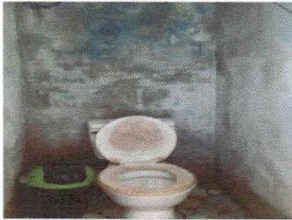
Foto 7: Sustitución de inodoro y azulejo
